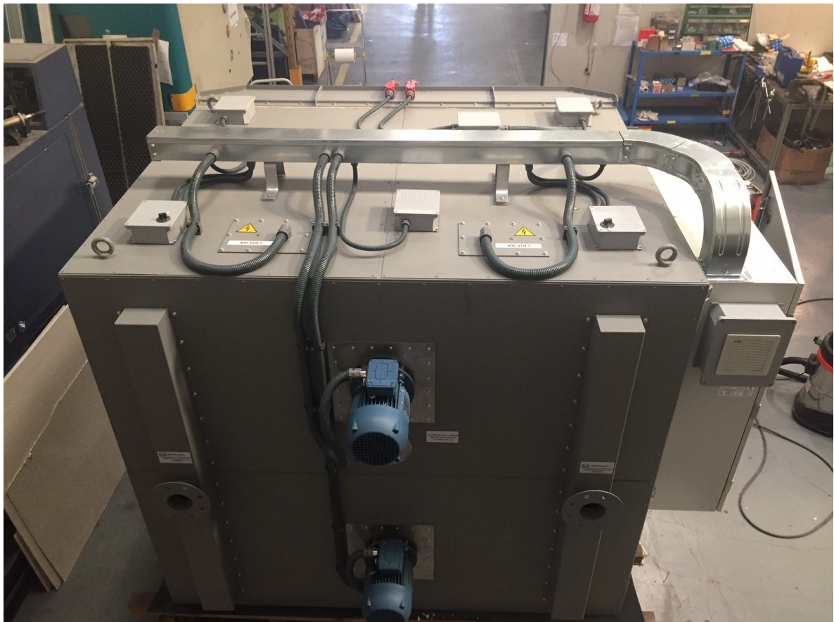
Foto 5 - collegamenti resistenze (di fabbrica)
